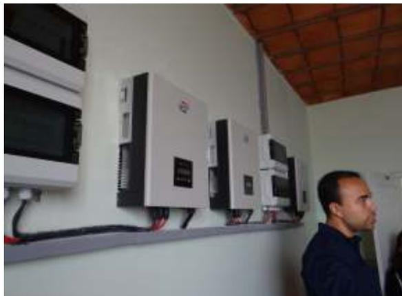
Próximo aos inversores, o engenheiro, Alexandre Andrade, da Solsist Engenharia, explica aos presentes a transformação da corrente contínua gerada nas placas, em 76 módulos de 320 Wp, gerando 2.683 kWh/mês, em corrente alternada semelhante à existente na rede da concessionária de energia.
